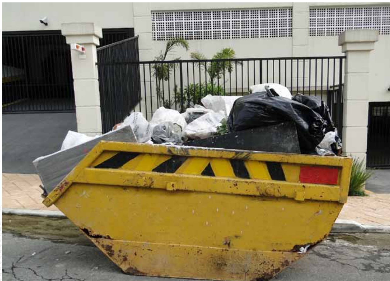
Organização e limpeza da obra evitam maior impacto no entorno
