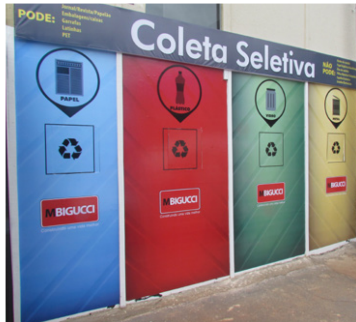
Coleta Seletiva para a comunidade foi instalada na frente do canteiro de obras
