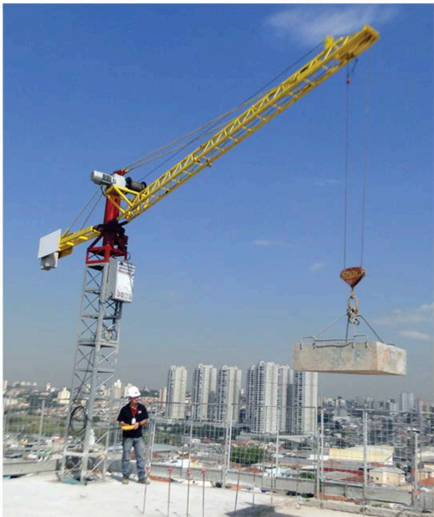
Obra do empreendimento residencial Piemonte M'Bigodi, em construção no Bairro Saúde / SP
