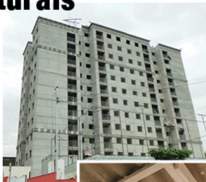
Instalado na obra Piemonte (B. Saúde/SP), o sistema capta água da chuva, por meio das calhas do telhado
