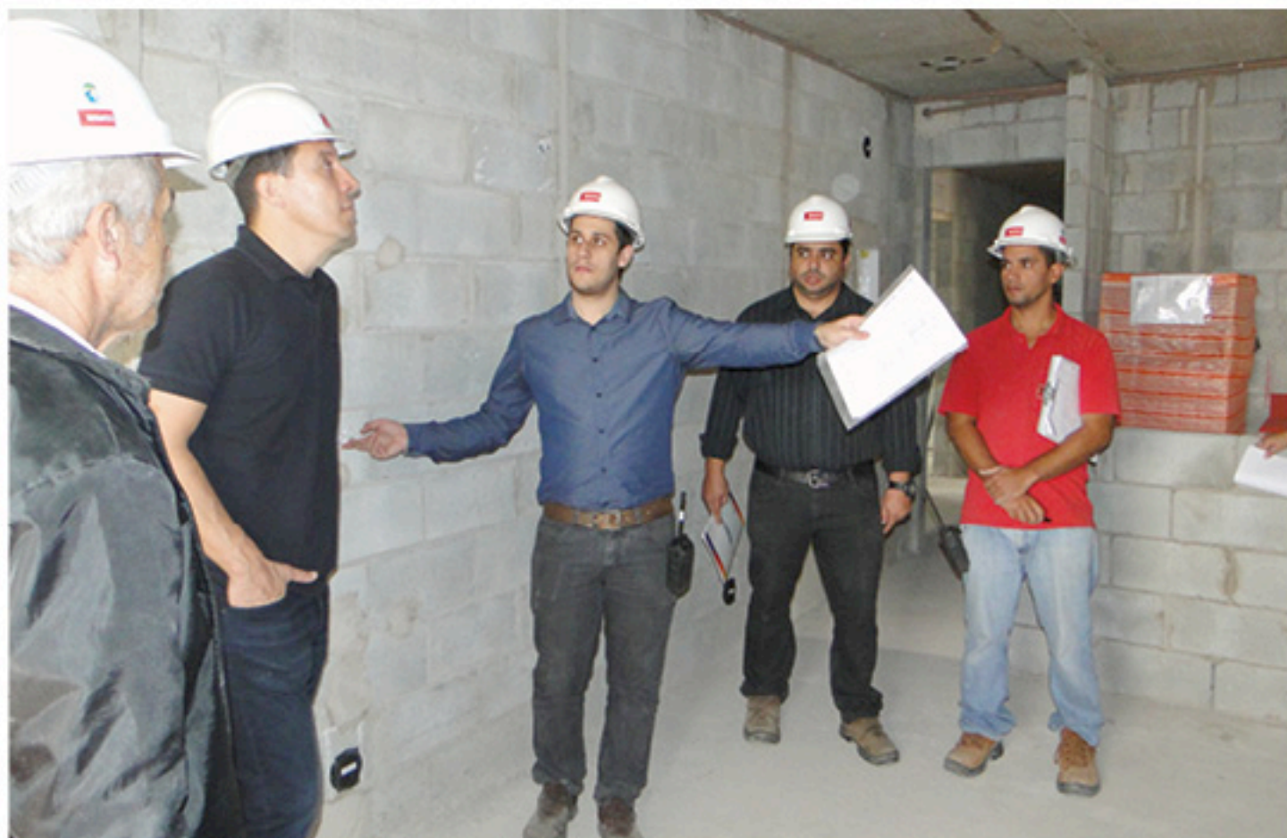
Equipe técnica valida apartamento protótipo do Impactus MBigucci, em construção em Santo André/SP
