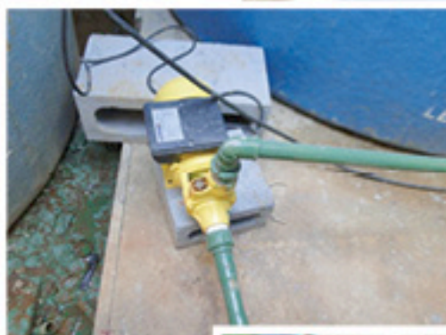
A água é armazenada em reservatórios no solo e depois é bombeada para uma caixa superior e utilizada para descargas e limpeza geral da obra
