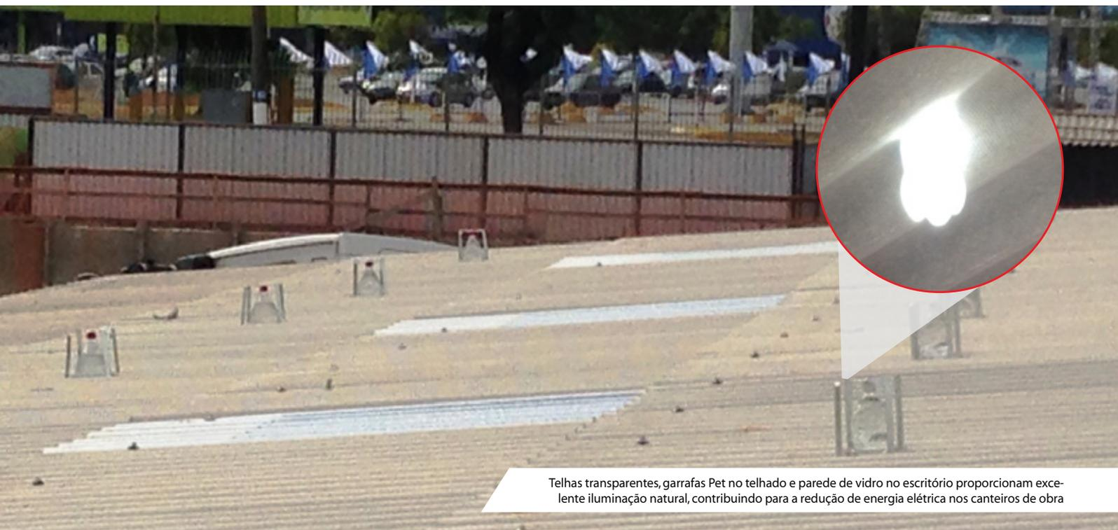
Telhas transparentes, garrafas Pet no telhado e parede de vidro no escritório proporcionam excelente iluminação natural, contribuindo para a redução de energia elétrica nos canteiros de obra
