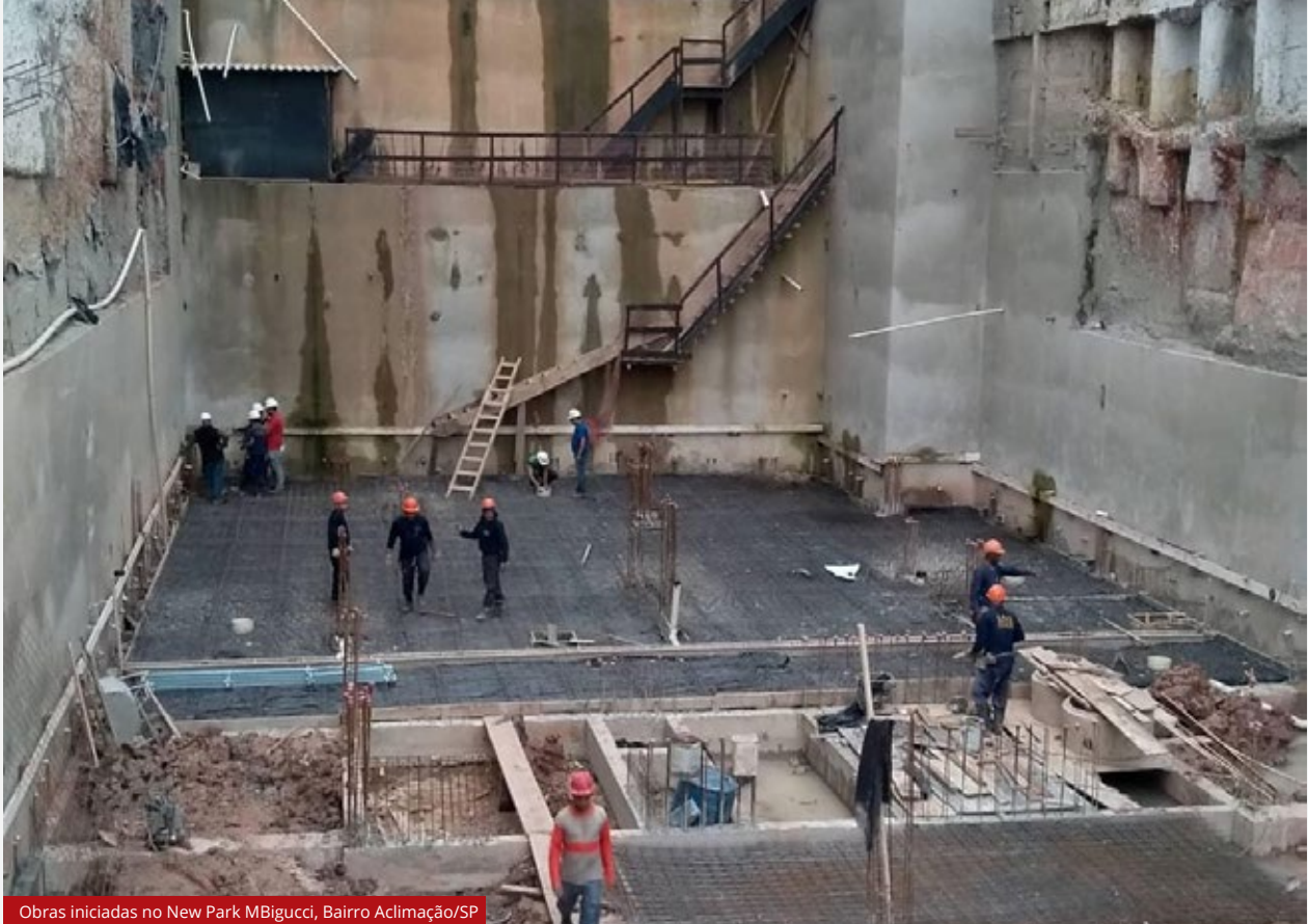
Obras iniciadas no New Park MBigucci, Bairro Aclimação/SP
