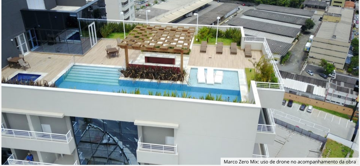
Marco Zero Mix: uso de drone no acompanhamento da obra
