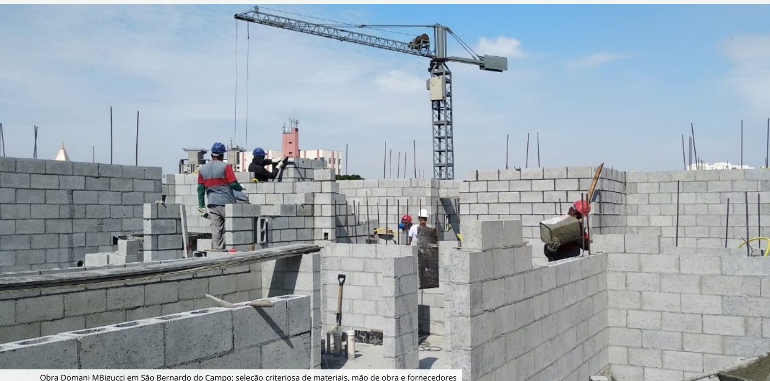
Obra Domani MBigucci em São Bernardo do Campo: seleção criteriosa de materiais, mão de obra e fornecedores
