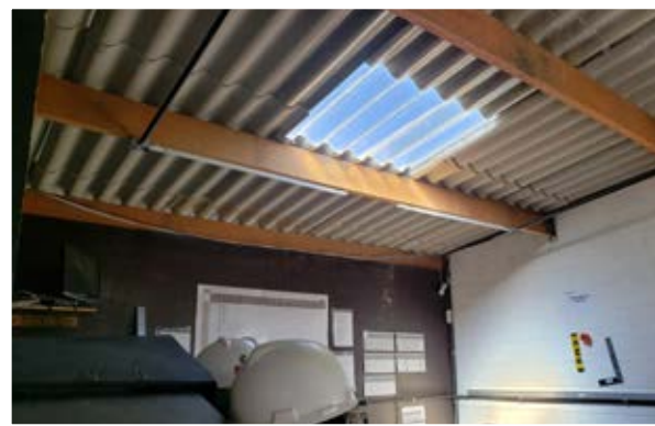
Iluminação natural com telhas translúcidas nos canteiros
